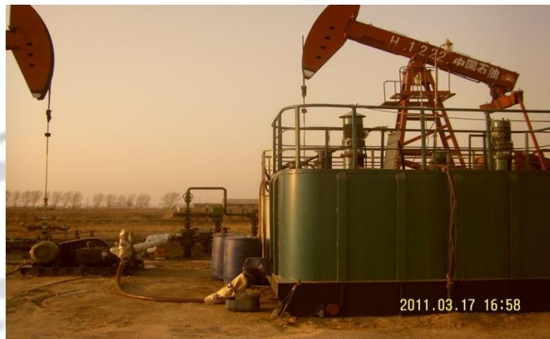
对大粒径颗粒及冻胶堵剂，在井口采用调剖泵施工。采用变频器（排量 $0-18\text{m}^3/\text{h}$ ; $0-30\text{MPa}$ ），按照配注低速注入。根据注入油压动态调整注入参数。
